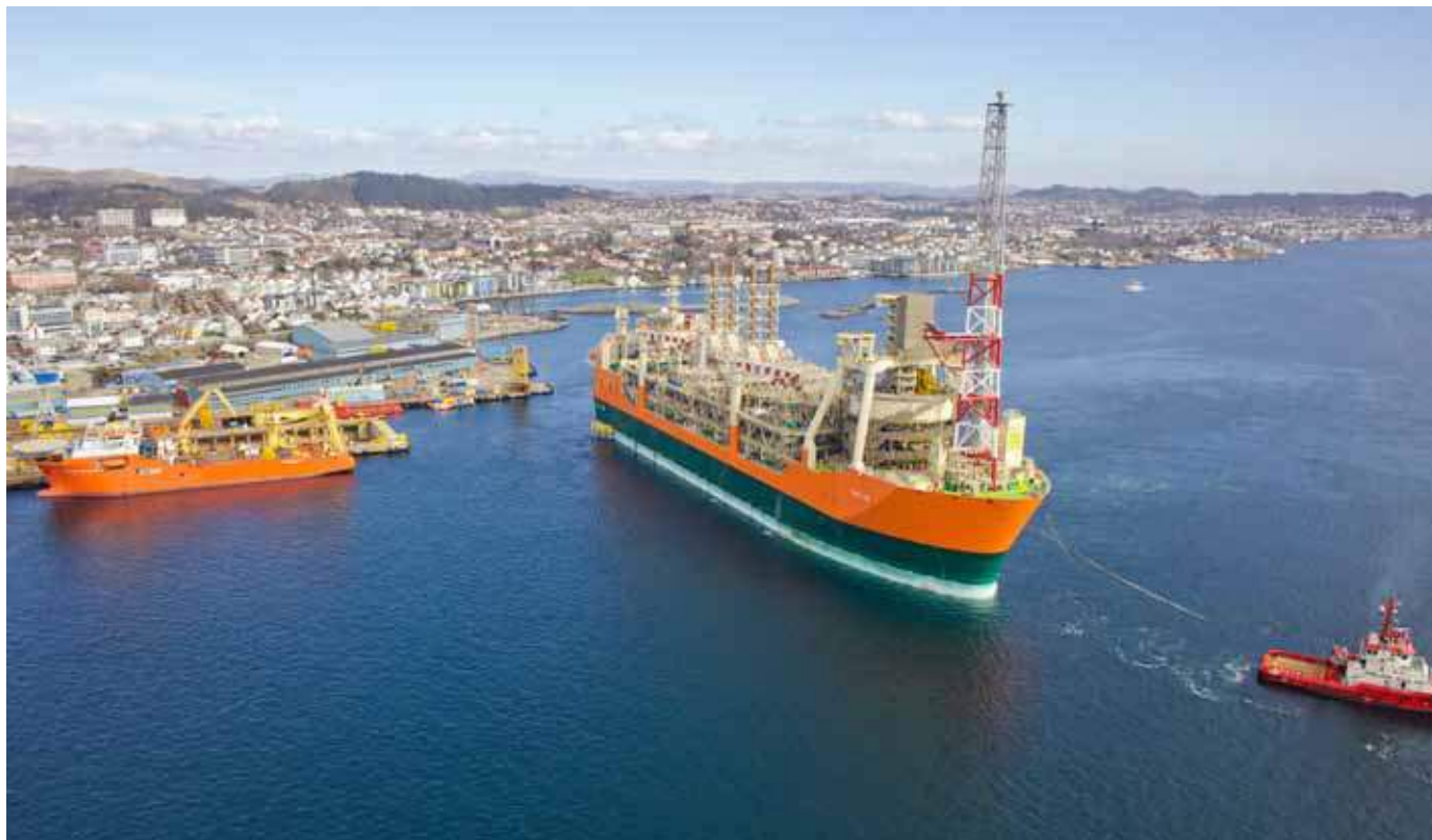
Produksjonsskipet Glen-Lyon er 270 meter langt og 52 meter bredt, og er det største skipet som noen gang har lagt til kai ved Aibels verft.
