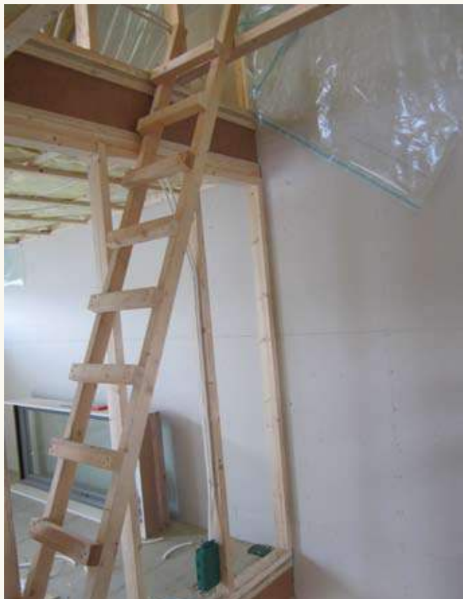
Fra byggeplass på Jæren.
