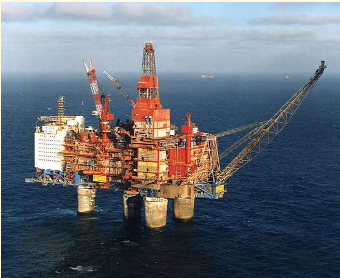
Gullfaks C plattformen. Foto: Statoil ved Dag Tore Arnfinssen.
