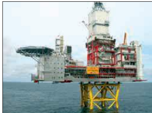
Kvitebjørn-dekket ble bygget ved ABB i Haugesund og er nå på plass offshore.
